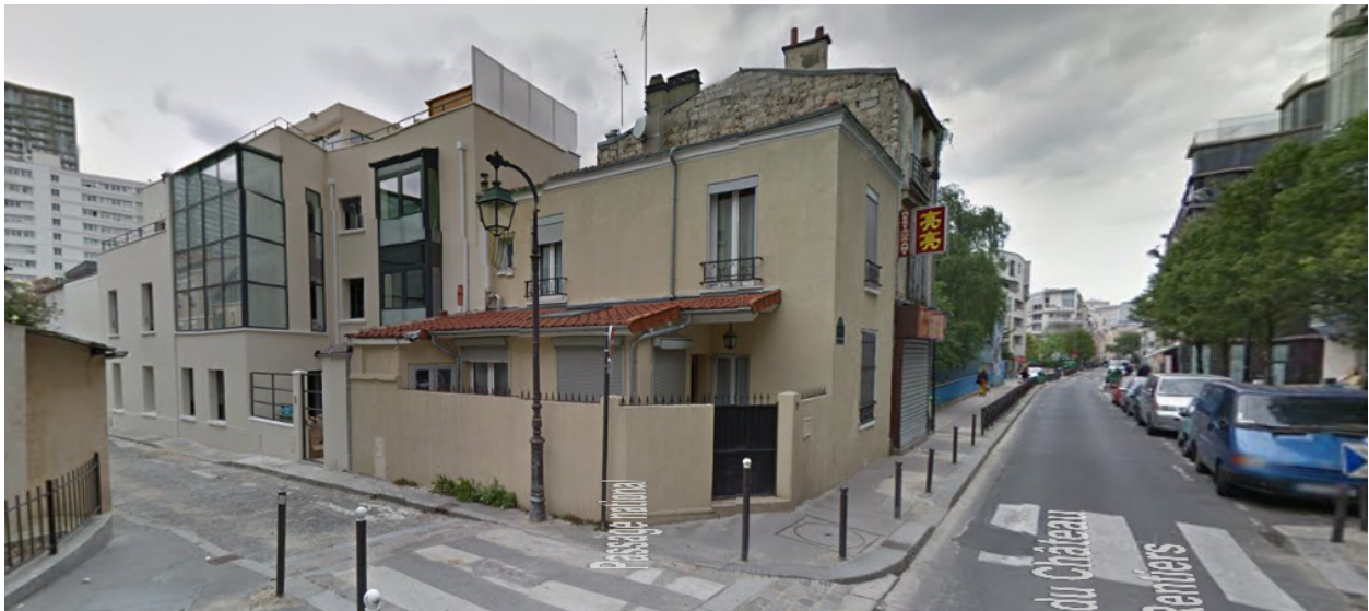
Rue du Château des Rentiers, Paris
